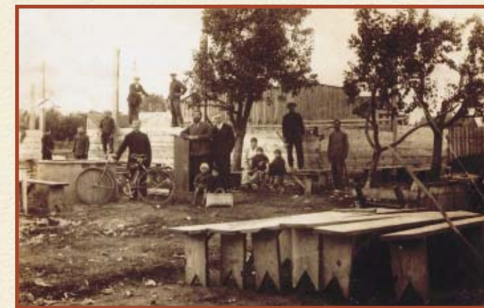
Начало строительства молитвенного дома по ул. Широкой. 1926 г.
