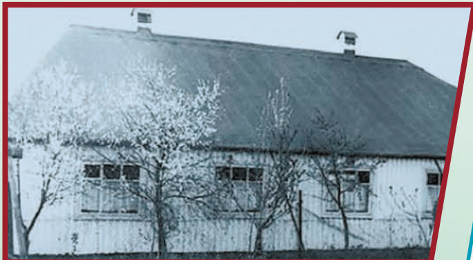
Этот дом был разрушен. (г. Иссык)
